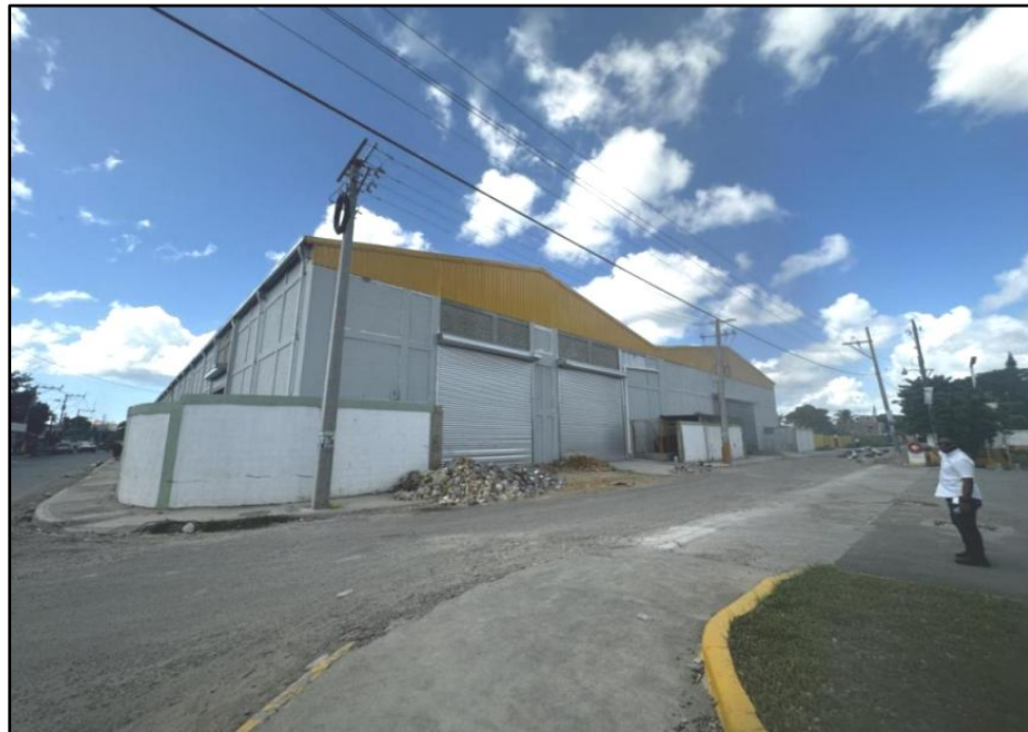
Foto 1.- Vista panorámica general de la nave industrial del proyecto.
