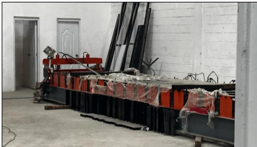
Foto 4.- Vista de una de las maquinas industriales del proyecto.
