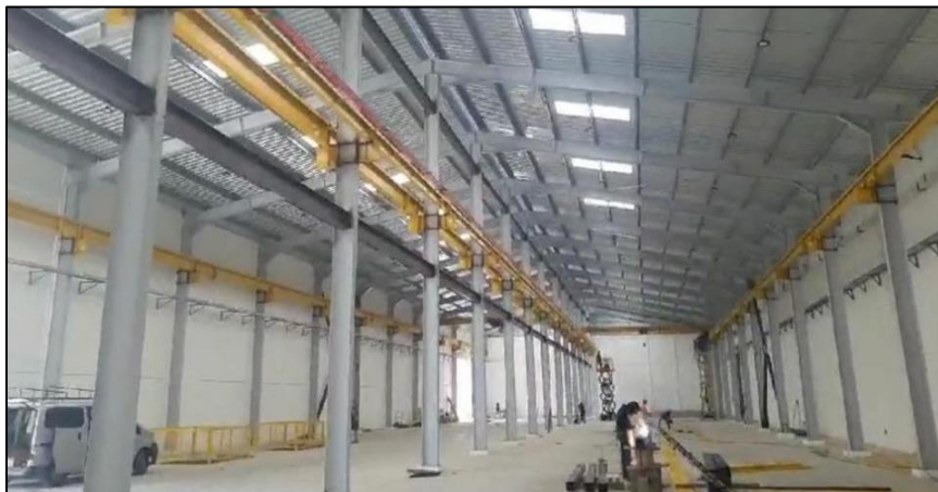
Foto 17.- Vista interior de la nave industrial, esta ocupa todo el terreno.
