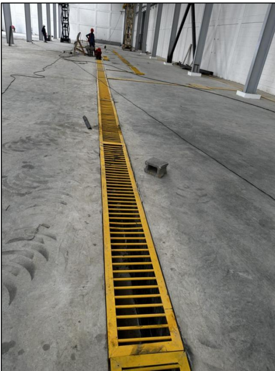
Foto 11 y Foto 12.- Fotografías de sistema drenaje interno en la nave industrial y de la cámara séptica respectivamente.
