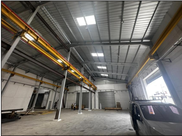
Foto 10.- Vistas del área de producción (Bodega I) de la nave industrial.
