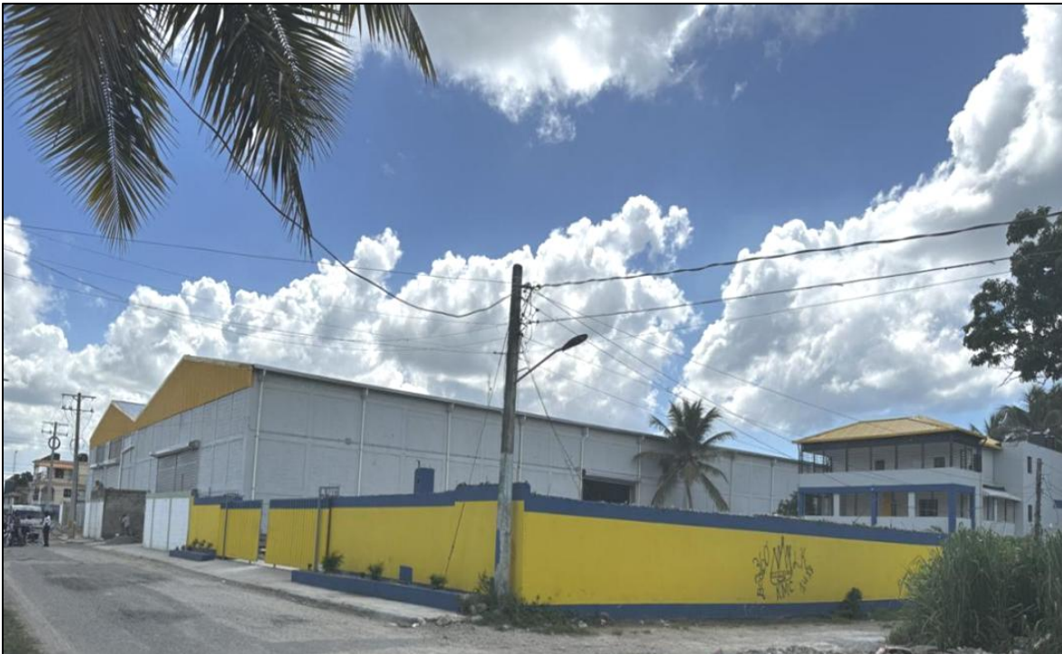
Foto 2.- Vista de la nave industrial de Aceros La República SAS en Boca Chica.
