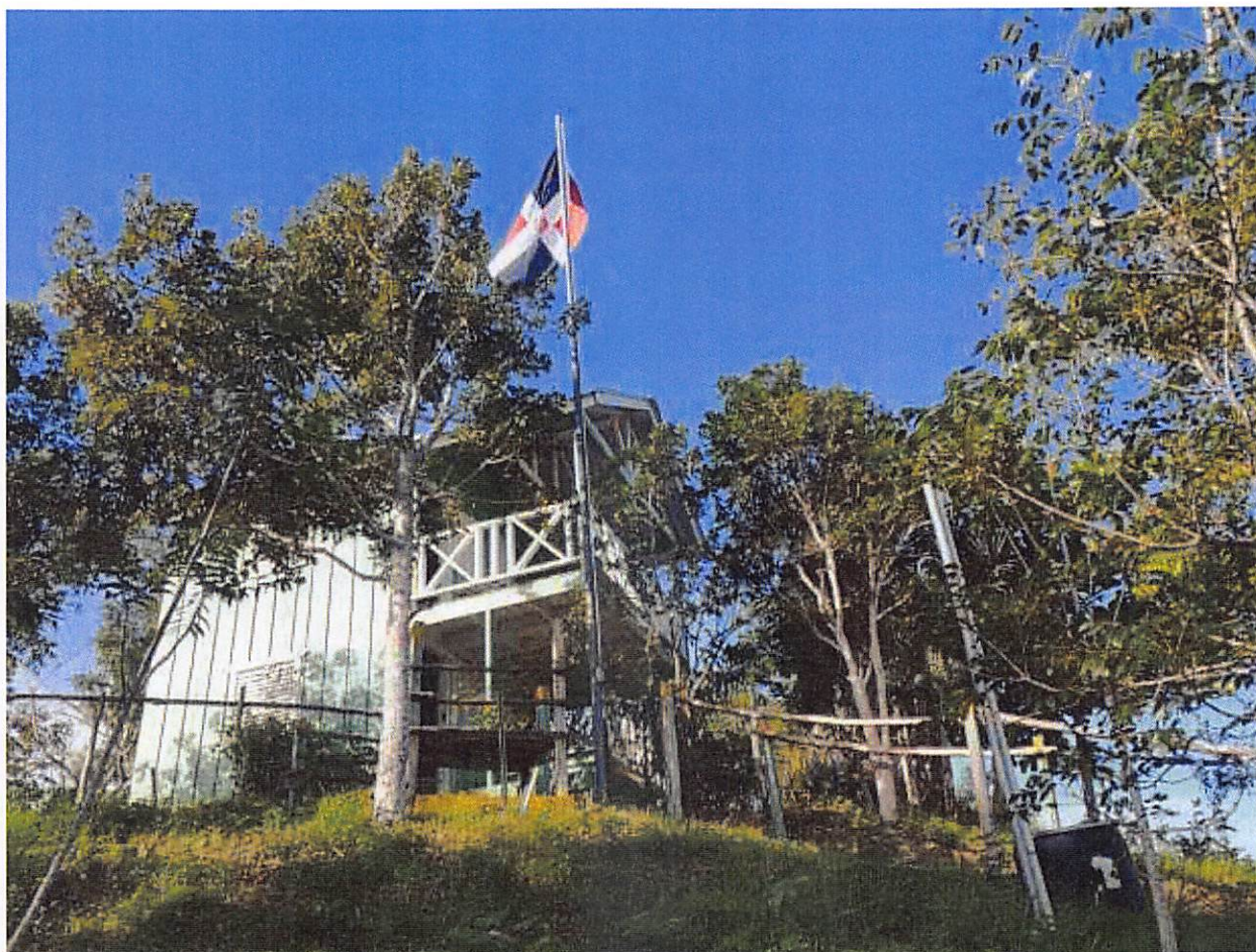
Foto 1.3. Caseta de vigilancia construida en el Sector La Piedra, del municipio Luperón, para la administración y vigilancia del área protegida RVSBL. Foto: Pedro Ramón Hernández.
