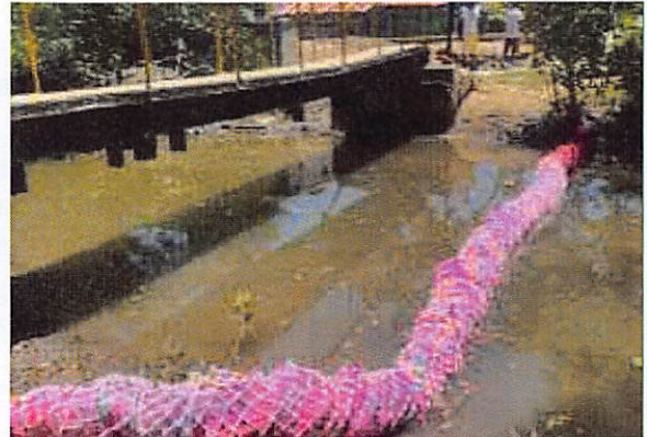
Colocación de biobarda en La Alhorrada
