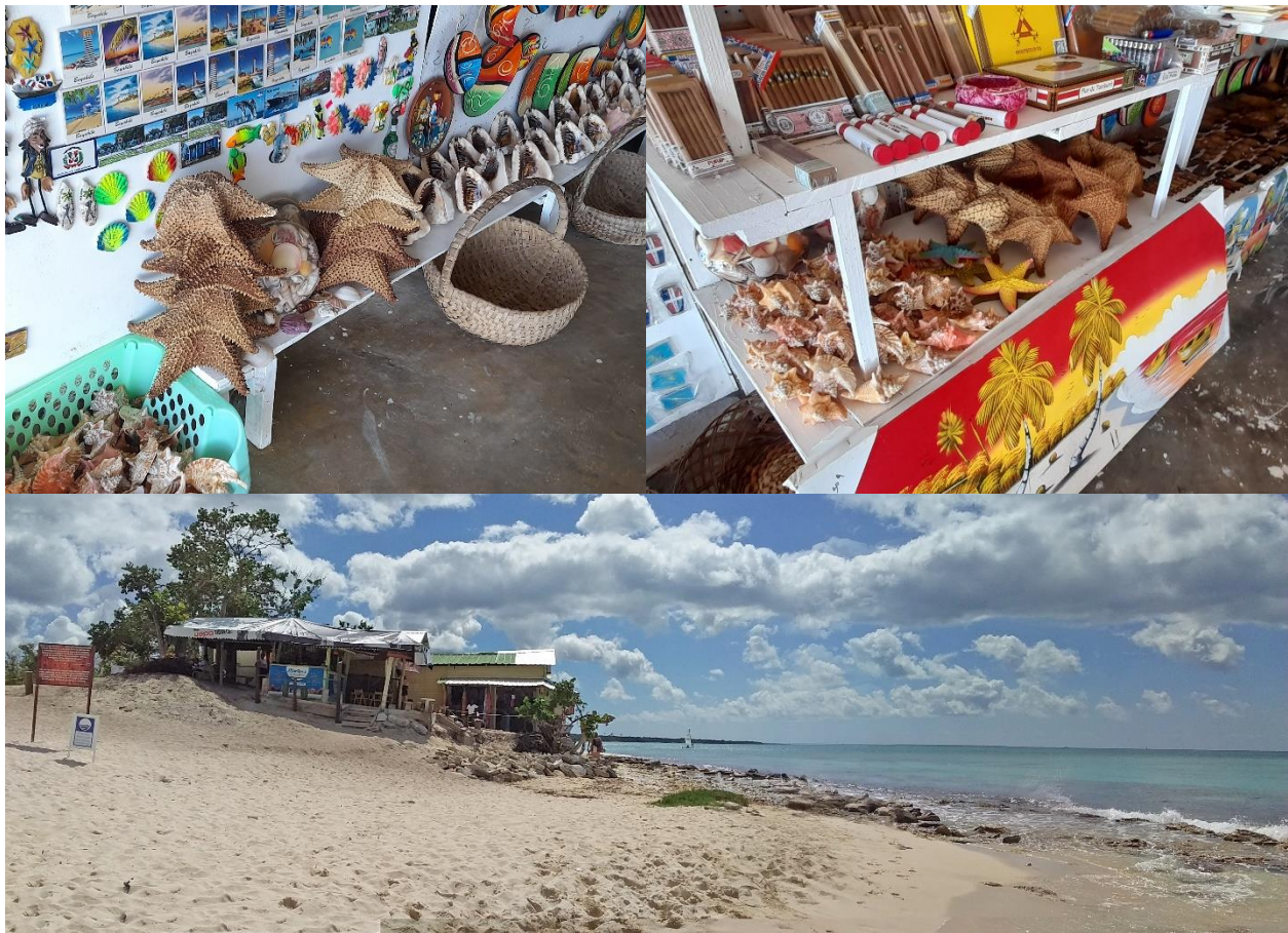
Foto 2.14. Arriba. Vistas de especies marinas en las tiendas de artesanías en playa Dominicus. Abajo. Construcción de las tiendas sobre la duna en el perfil de la playa con consecuencias de erosión. Fuente. Trabajo de campo.
