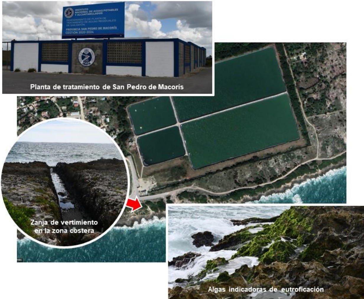
Foto 2.18. Vistas de la planta de tratamiento de San Pedro de Macorís, el sitio de vertimiento y la situación de la costera sobre la imagen aérea de Google Earth. Fuente: Trabajo de campo.
