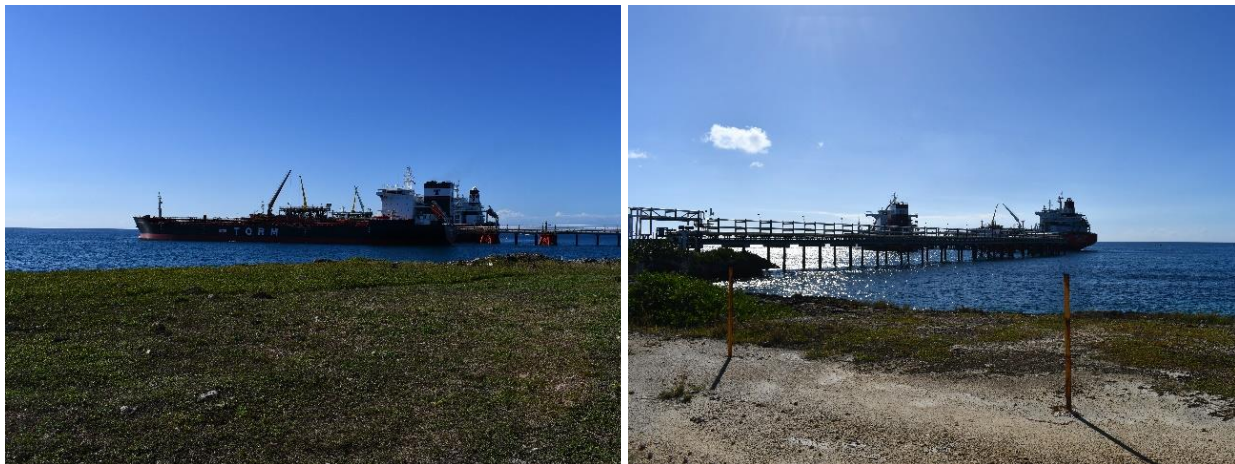
Foto 3.3. Instalaciones en el puerto La Cana de la empresa Coastal Petroleum Group dedicada a operaciones de descarga, almacenaje y preparación de productos derivados del petróleo. Fuente: Trabajo de campo.
