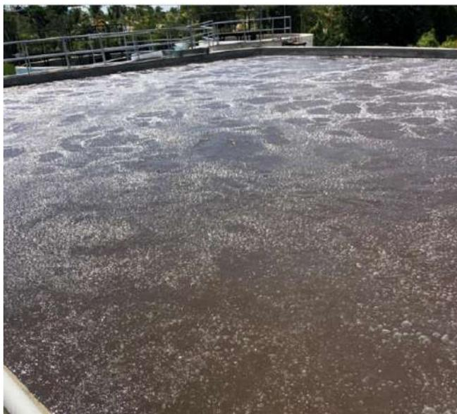
**Figura 3.** Fotografía de un tanque de aireación (ilustrativa)
