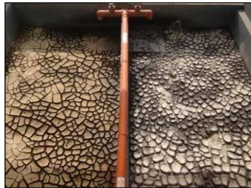
**Figura 7.** Izquierda. Fotografía de unos lechos de secado (ilustrativa). Derecha. Fotografía de lechos de secado con biosólidos (lodo seco) y biosólidos higienizados con cal (ilustrativa).
