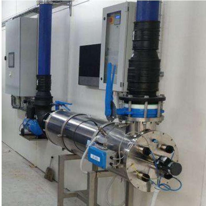
**Figura 7.** Fotografía de un sistema de desinfección por luz UV.
