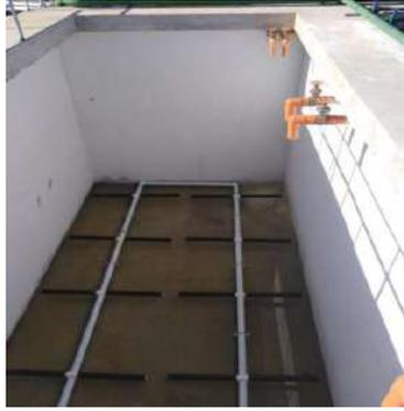
**Figura 6.** Fotografía de un digestor aeróbico previo al arranque de la PTAR (ilustrativa)
