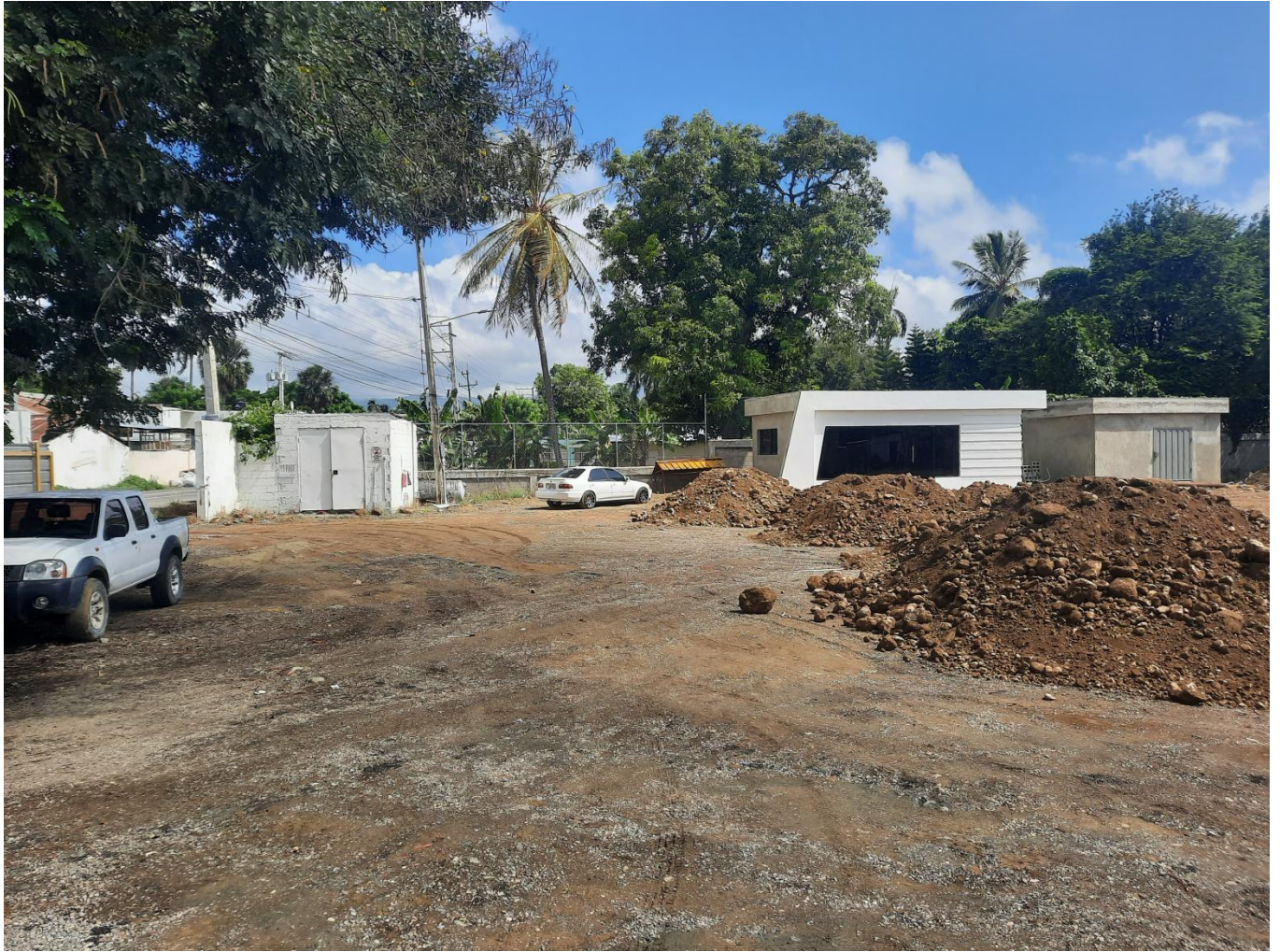
Vista del area de la Envasadora CREDIGAS LICEY en reparacion actualmente
