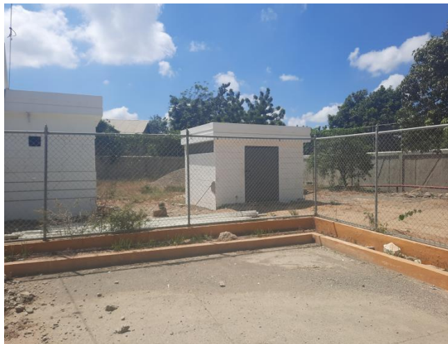
Caseta de Planta de Emergencia
