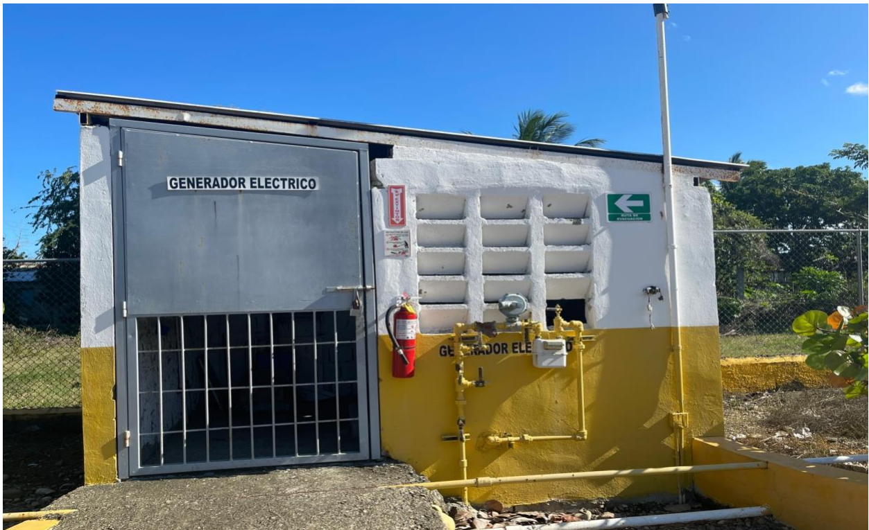
Foto: Edificaciones caseta del generador.
