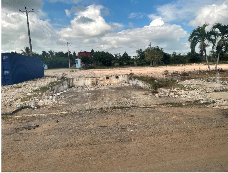
Imagen No. 20. Área donde fue realizada demolición de estructura anterior
