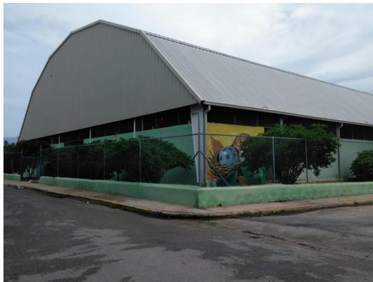
Imagen no. 50. Multisusos Municipal de Pedernales. Fuente: VLora Estudio de Arquitectura
