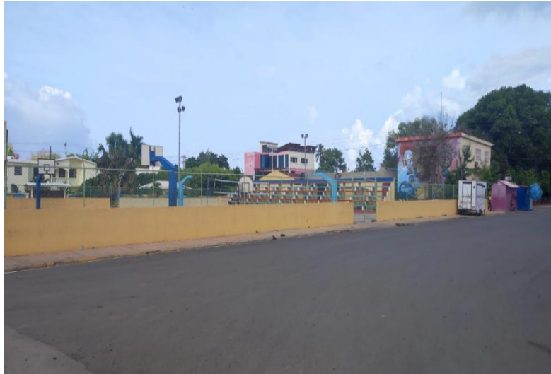
Imagen no. 51. Cancha de Baloncesto Municipal de Pedernales. Fuente: VLora Estudio de Arquitectura
