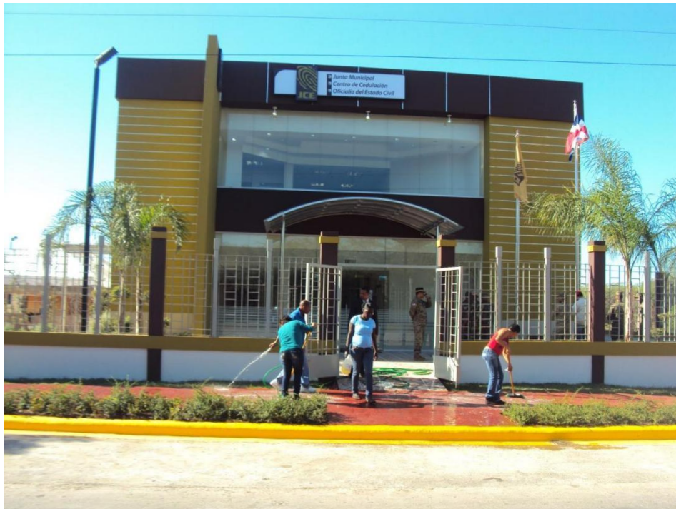
Imagen no. 67. Junta Central y Electoral de Pedernales . Fuente: VLora Estudio de Arquitectura
