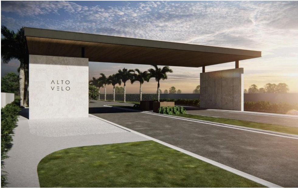
Imagen No. 6. Entrada Principal. Fuente: VLora Estudio de Arquitectura.
