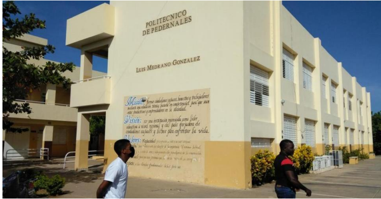
Imagen no. 56. Politécnico Luis Medrano González. Fuente: VLora Estudio de Arquitectura
