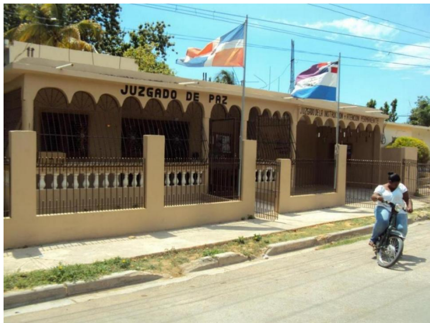
Imagen no. 59. Juzgado de Pedernales. Fuente: VLora Estudio de Arquitectura
