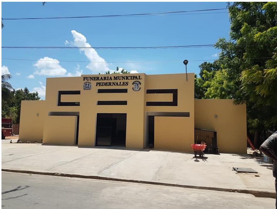
Imagen no. 65. Funeraria Municipal de Pedernales. Fuente: VLora Estudio de Arquitectura
