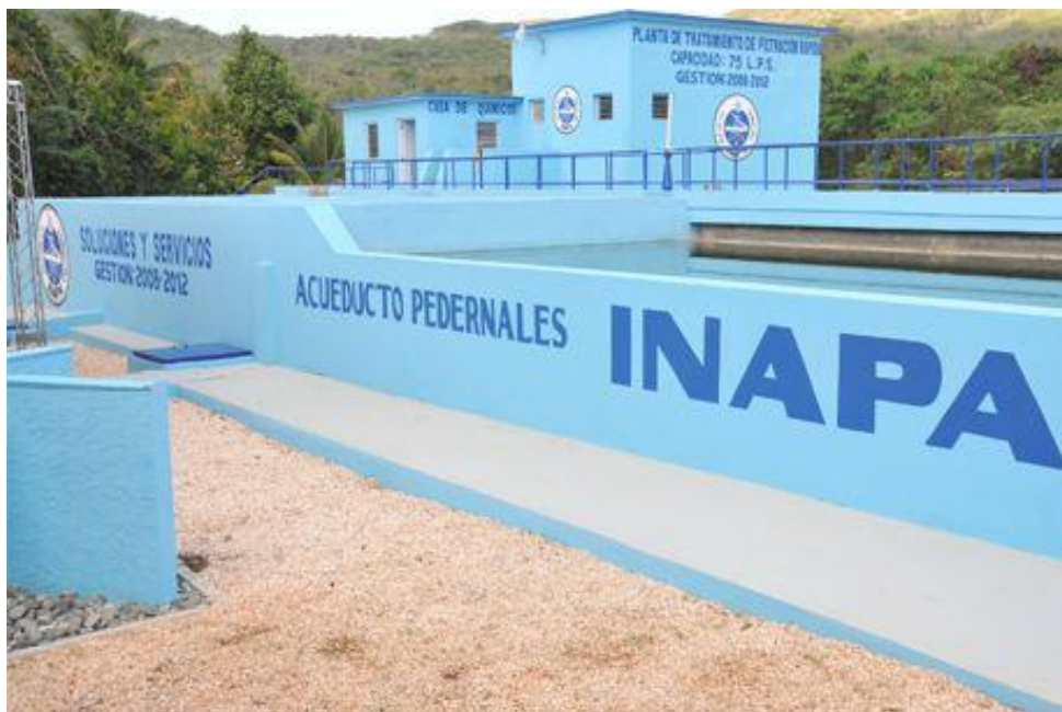
Imagen no. 69. Acueducto (INAPA) de Pedernales. Fuente: VLora Estudio de Arquitectura
