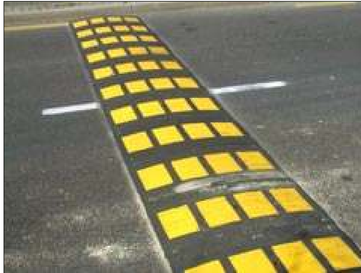
Foto 6.6.5.2-1. Vista de un policia acostado utilizado como método de control de velocidad.
