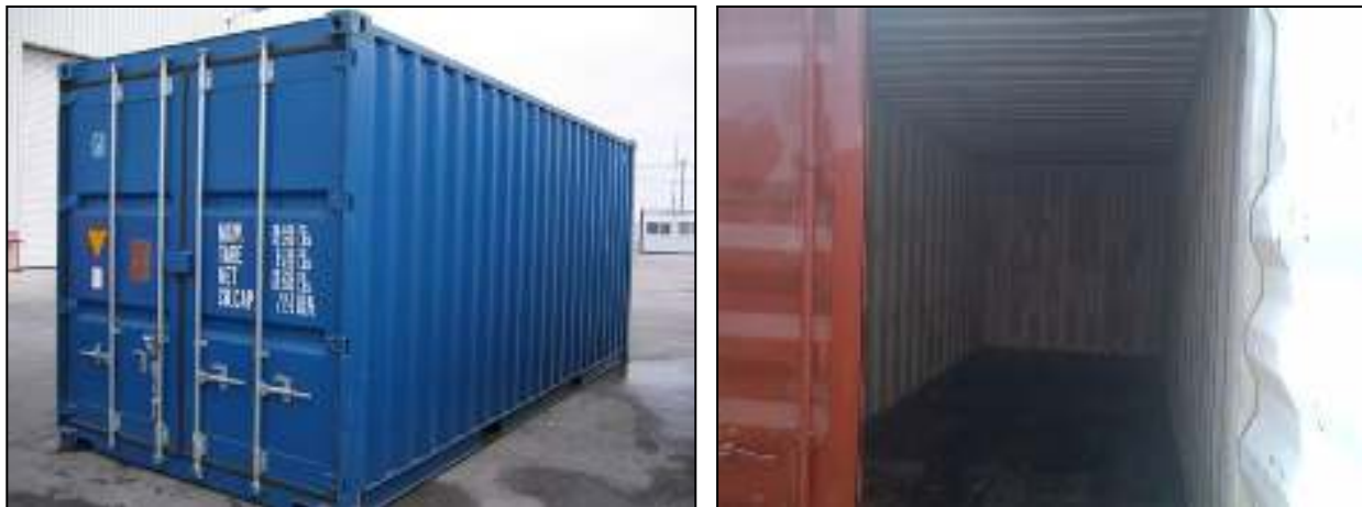
Fotos 1.13.2.1-2. Tipo de furgones utilizados para almacenar materiales de construcción en una obra.
