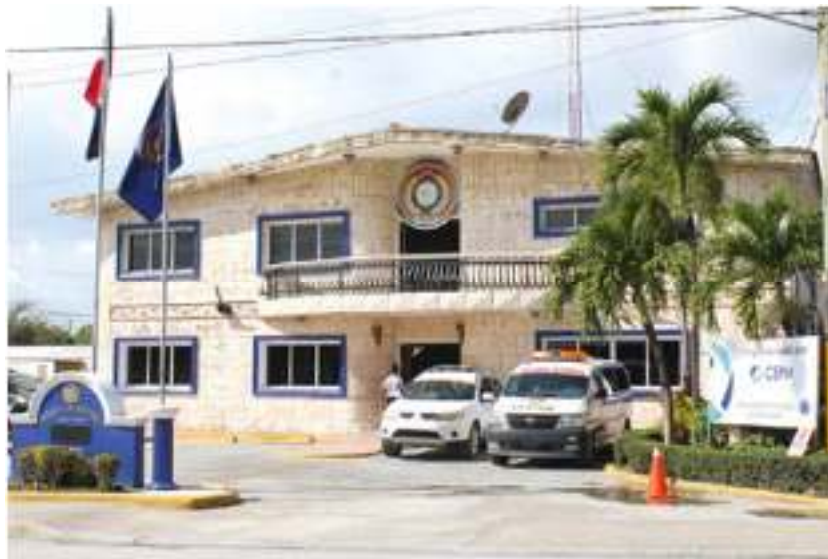
Foto 2.5.5.8-1-1. Edificio del Cuerpo Especializado de Seguridad Turística en el distrito municipal Verón-Punta Cana.
