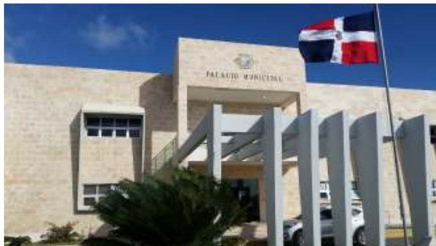
Foto 2.5.5.7-1. Edificio oficina municipal Verón-Punta Cana.
