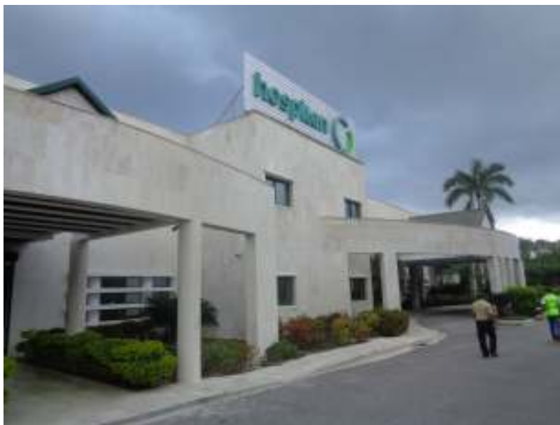
Foto 2.5.5.9-1. Edificio de Hospiten Bávaro-Punta Cana.
