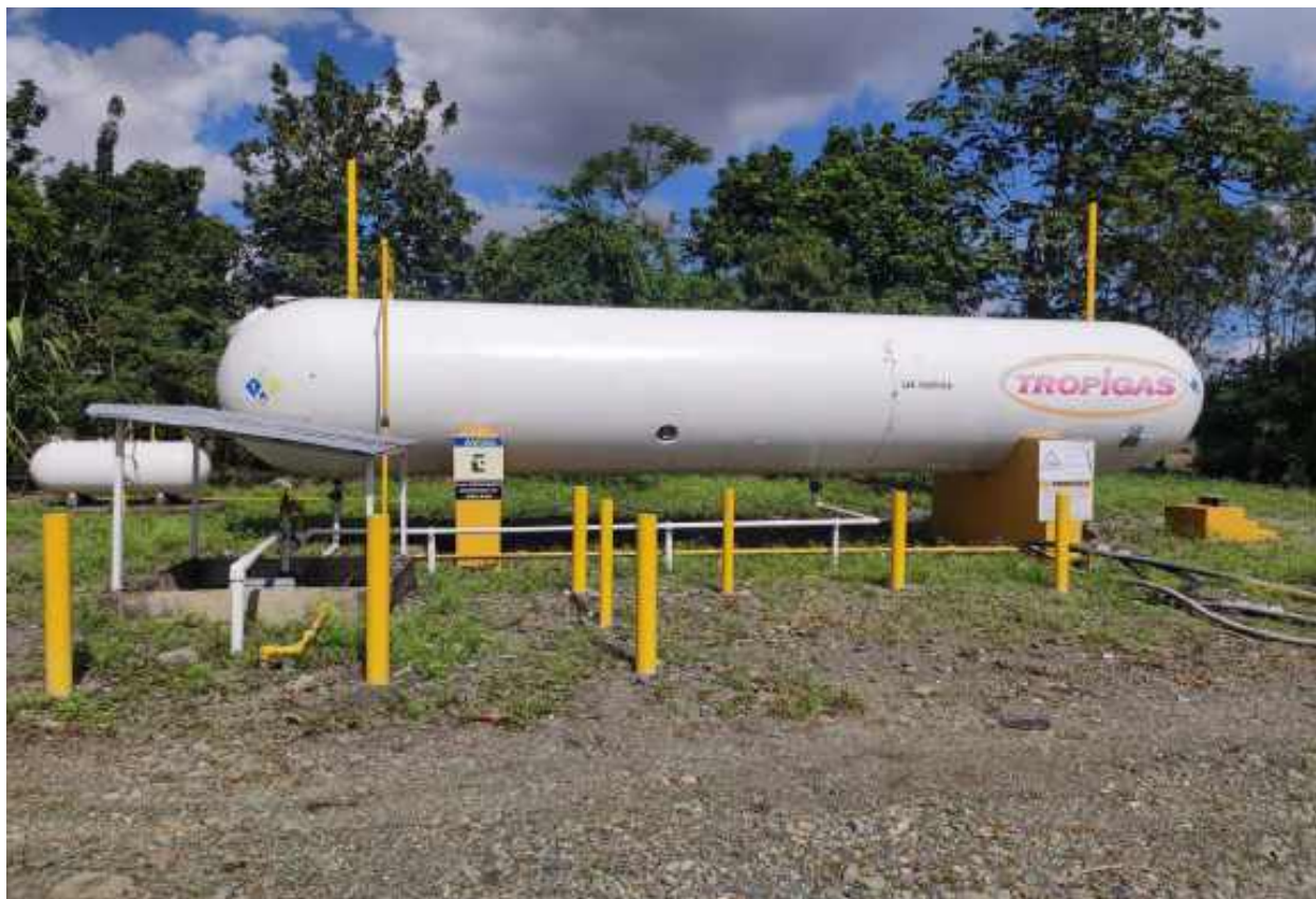
Foto: Área de tanque de GLP, y tanque de GLP del generador.
