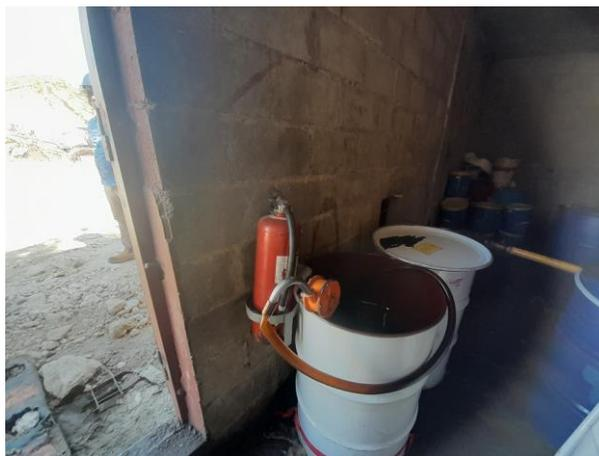
**Foto 7.5-2.** Extintor de incendios en el cuarto de almacenamiento de combustible.
