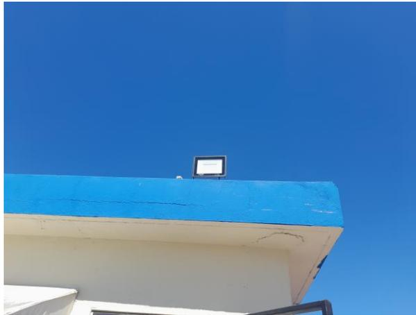
**Foto 7.7-2.** Utilización de lámparas de iluminación exterior con fotoceldas en las instalaciones del proyecto.
