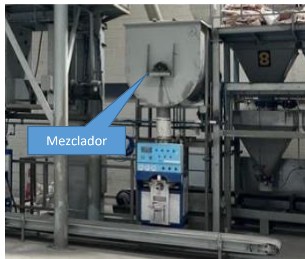
Foto No. 9.- Contenedor donde se realiza la mezcla
