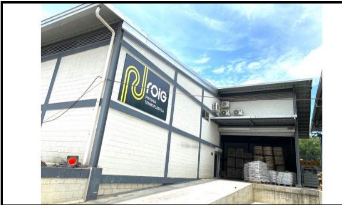
Foto No. 1.- Edificación de la Industria Roig Industrial, SRL.
