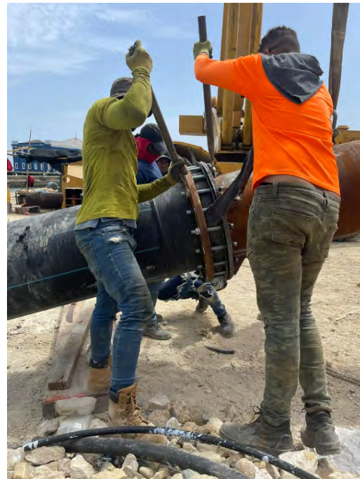
Imagen 73. Acople entre tramos de mangueras para dragado y succión de materiales.
