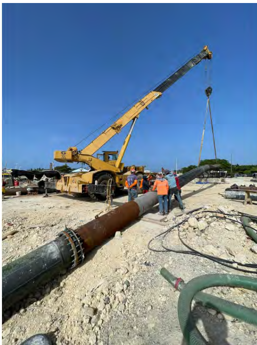
Imagen 73. Acople entre tramos de mangueras para dragado y succión de materiales.
