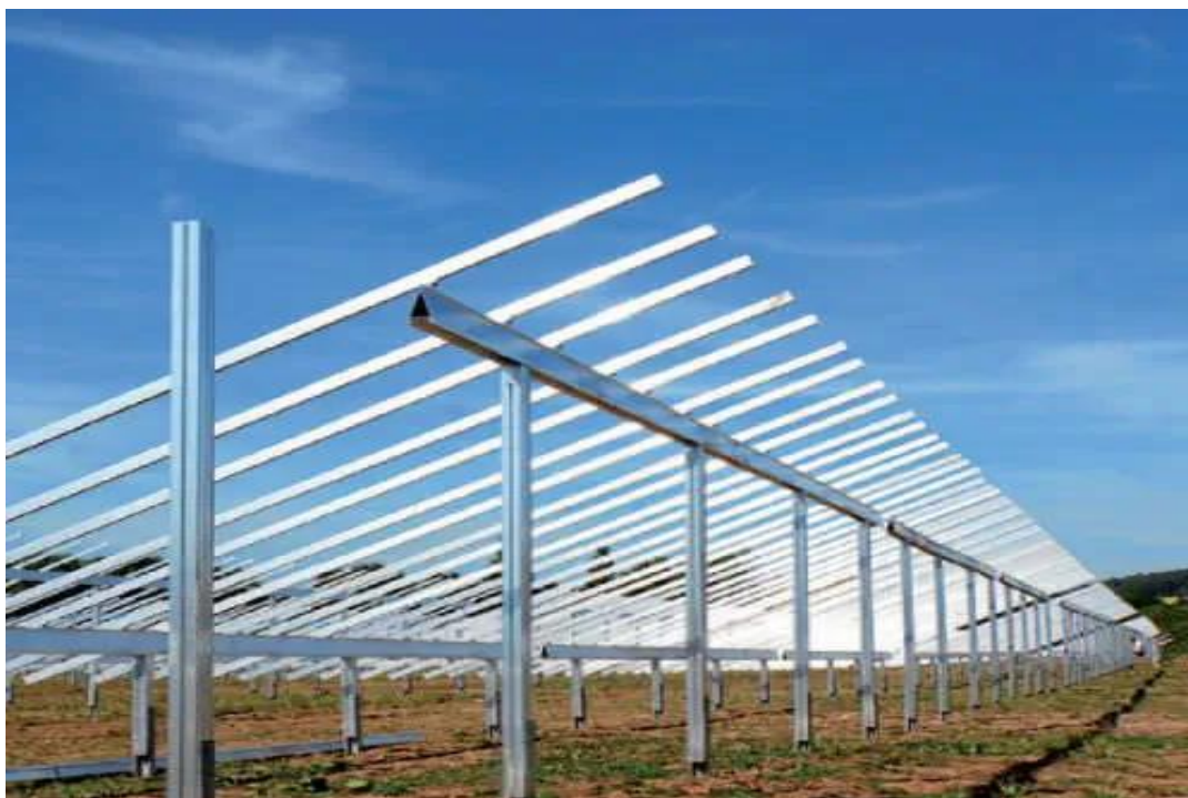
Vista de cómo serán instalados los Perfiles.
