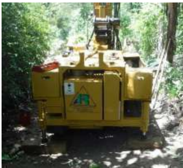
Imagen No.1-2: Equipo de perforación ROLATEC RL-48L-2010, emplazado el Sondeo No.1
