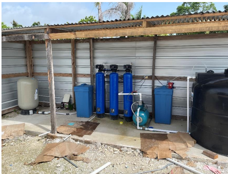
Sistema de tratamiento osmosis en fase de construcción
