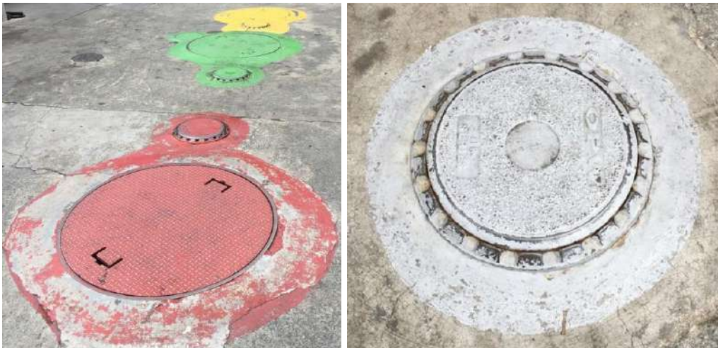
Figura 3. Tapas de llenado de tanques soterrados de almacenamiento de combustible
