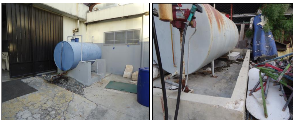
Vista de los tanques de almacenamiento de combustible de los generadores y vehículos
