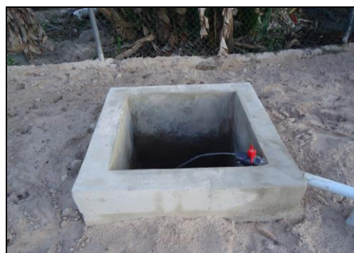
Vista del sistema de descarga final de las aguas residuales al subsuelo
