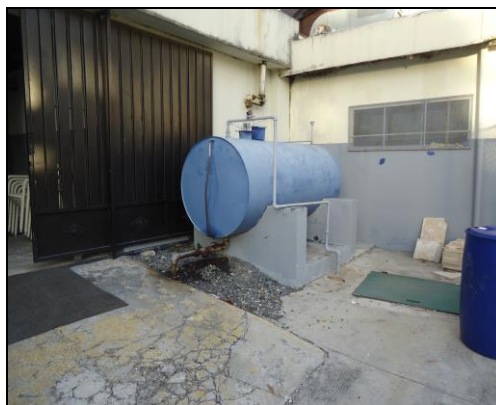
Vista de los tanques de almacenamiento de combustible de los generadores y vehículos
