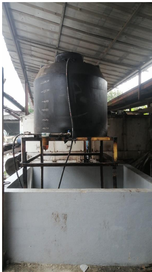
Foto 2.19.2. Área de combustible 1 tanque de 500 galones
