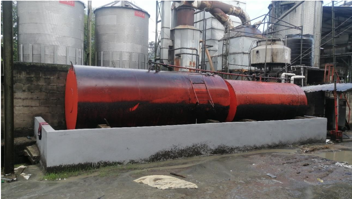
Foto 2.19.1. Área de combustible 2 tanques de 5,000 galones
