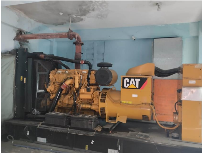
Foto: Generador eléctrico de emergencia.
