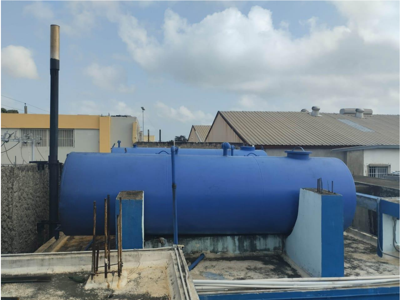
Tanque diesel aereo para el generador
