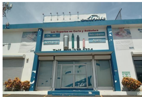
Figura 22: Vista general de Linde Gas Dominicana SRL (localidad Santiago).
