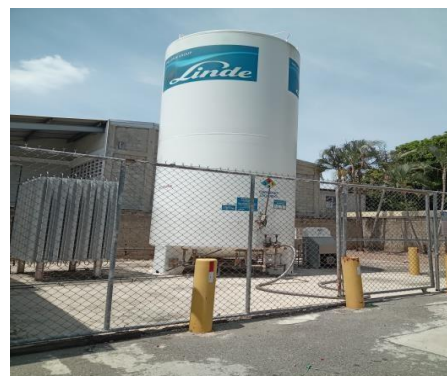
Figura 23: Tanque estacionario de Linde Gas Dominicana SRL (localidad Santiago).
