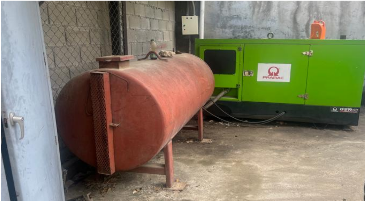
Generador de 50 Kw/h y Tanque de almacenamiento de 100 galones
