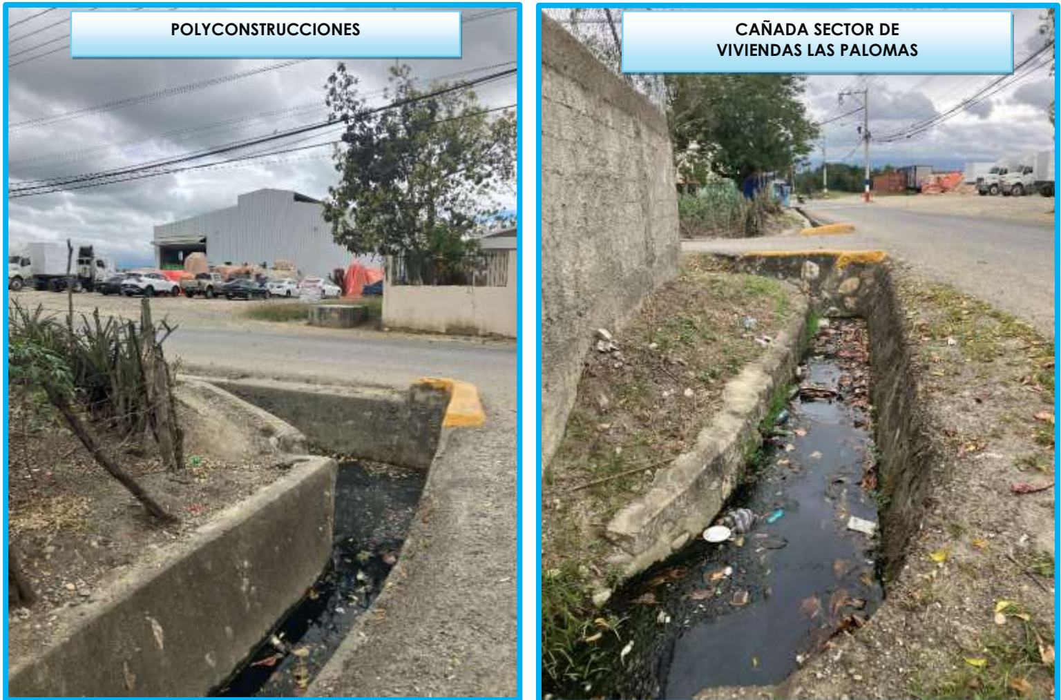
Imagen No. 60-61: Cañada
