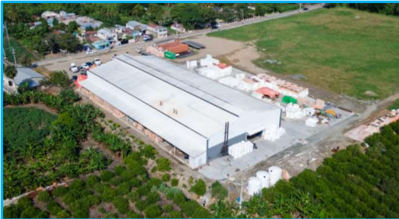
Imagen No. 11: Vista del Proyecto
