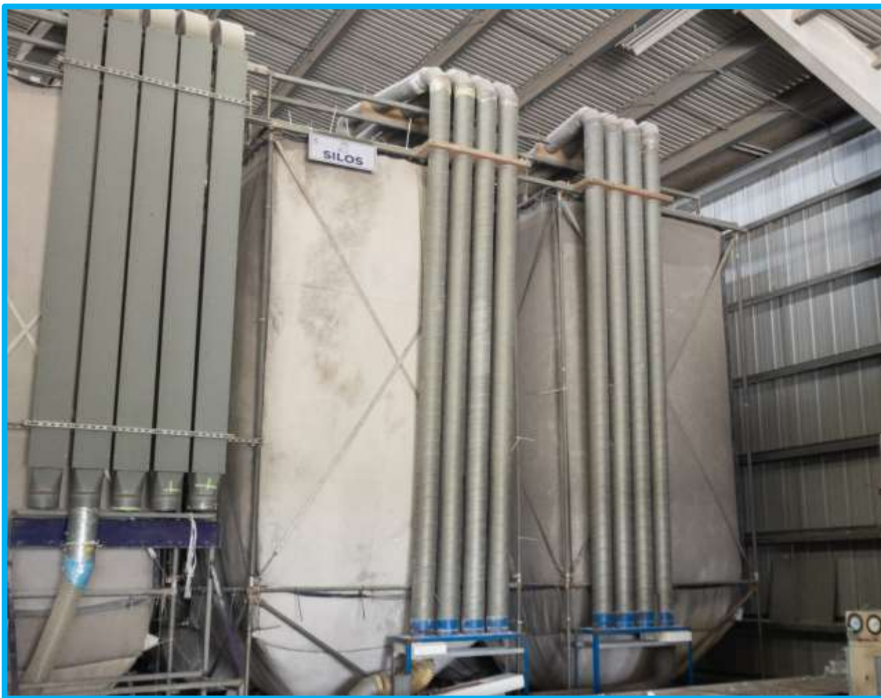
Imagen No. 29: Silos
