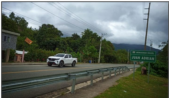
Foto 1.28 (2) Sistema de distribución eléctrica en paralelo a las vías a la izquierda 12.5 kW y a la derecha 34.5 kW
