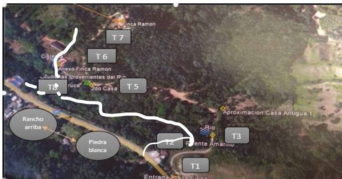
Fuente: Infraestructuras existentes (Imagen tomada de Google)
