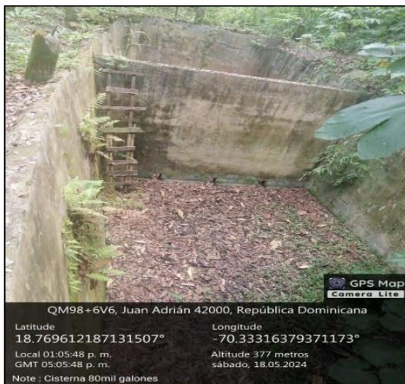
Foto 2.12B Cisterna A4 (en desuso)
