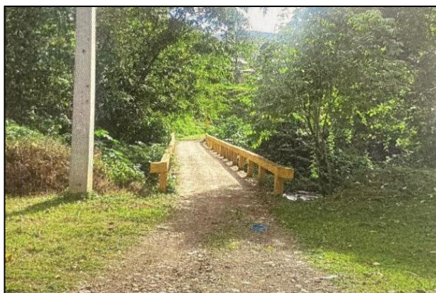
Foto 1.10 Puente sobre el Río Maimón
