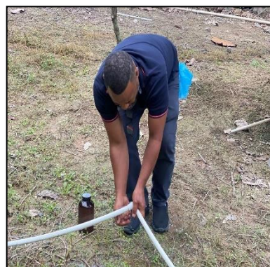
Foto 2.23 Tubería de conexión de agua a la entrada del proyecto
