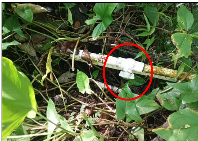
Foto 1.26C Área conexión primaria Tuberías - Acueducto y áreas del proyecto
