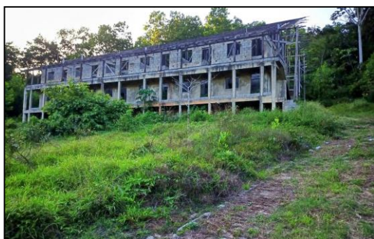
Foto 1.8A Vista Frontal del Hotel en Construcción
