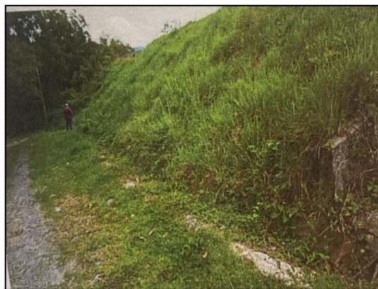
Foto 2.18 Cuneta de drenaje al fondo del pie del talud
