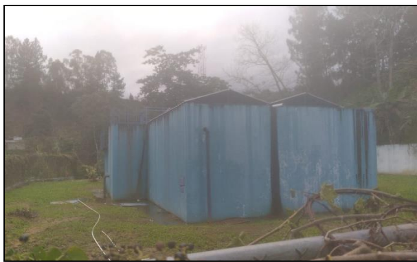
Foto 2.22 Acueducto de Juan Adrián
