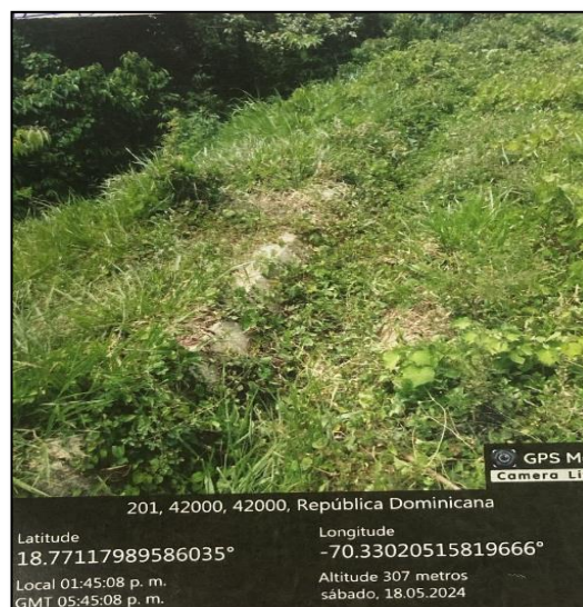
Foto 2.20 Estructura de caída No. 2 Caída de Drenaje
