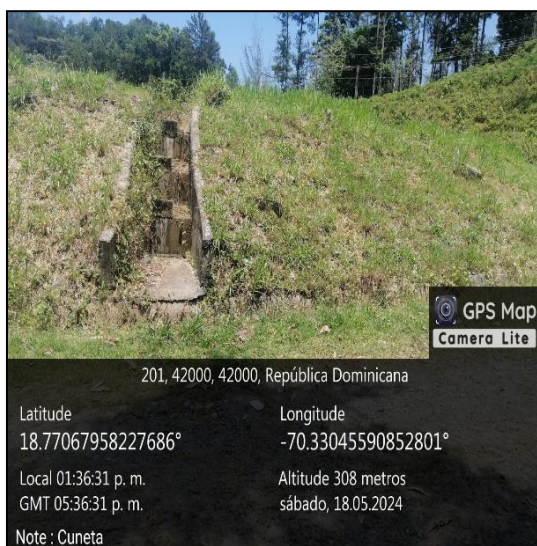
Foto 2.19 Estructura de caída No.1 drenaje
