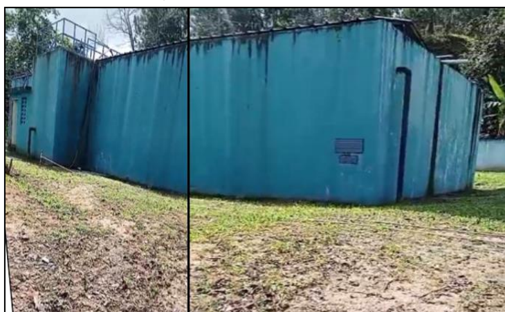
Foto 1.19 Vista Acueducto de Juan Adrián
