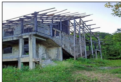
Foto 1.8B Vista Lateral del Hotel en Construcción
