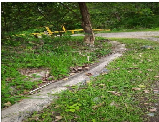
Foto 2.17 Cuneta que bordea la vía de acceso (parte baja)
