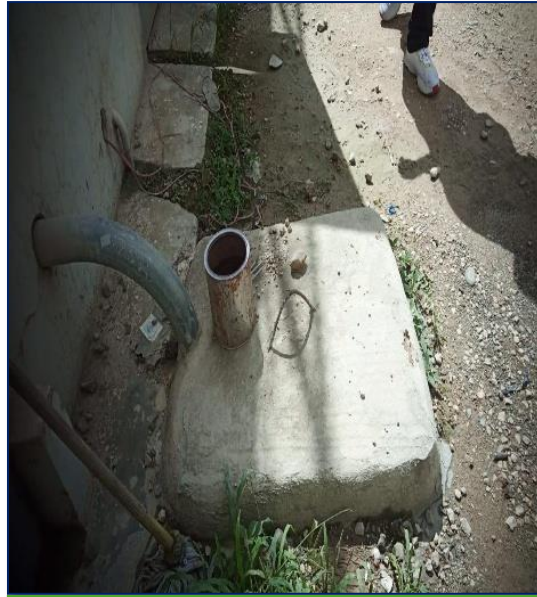
Foto 2.24C Tubos de Descarga de Líquidos Oleosos
