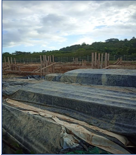
Foto 2.1 Vista de la construcción del área ampliación
