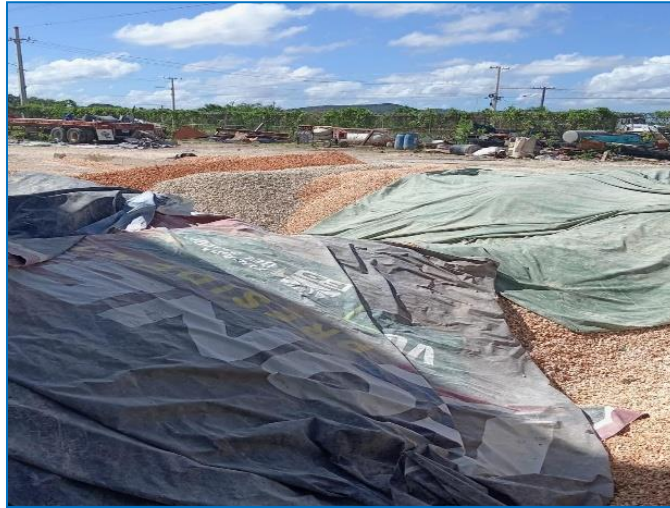
Foto 6.10 Protección con Lona en Arena y Grava
