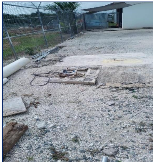
Foto 4.4 Cisterna Agua de Almacenamiento
