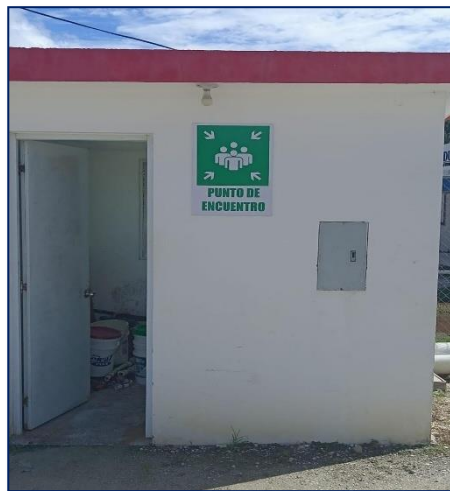
Foto 2.27B Señalización Lugar Punto de Encuentro
