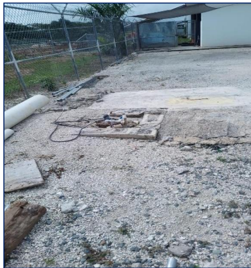
Foto 4.4 Cisterna Agua de Almacenamiento
