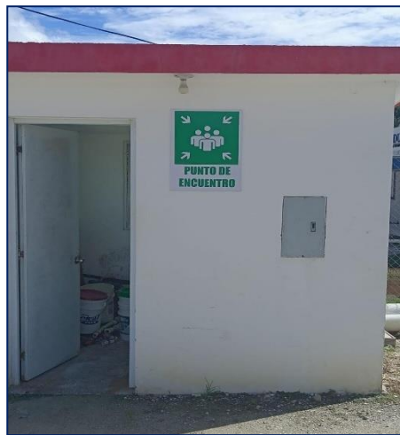
Foto 2.27B Señalización Lugar Punto de Encuentro
