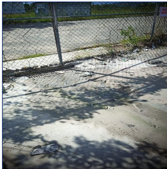
Foto 4.15 Punto de Descarga al Destino Final en la Calle
