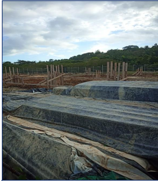
Foto 2.1 Vista de la construcción del área ampliación
