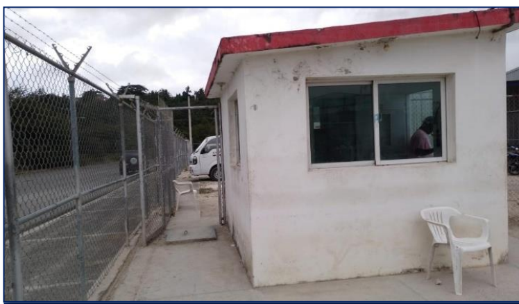
Foto 2.29 Garita de Seguridad
