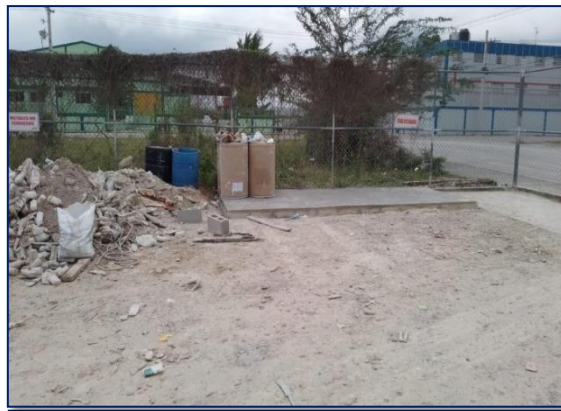
Foto 4.21F Construcción Base de Cemento Residuos Solidos
