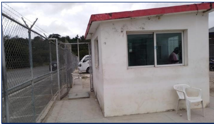
Foto 2.29 Garita de Seguridad
