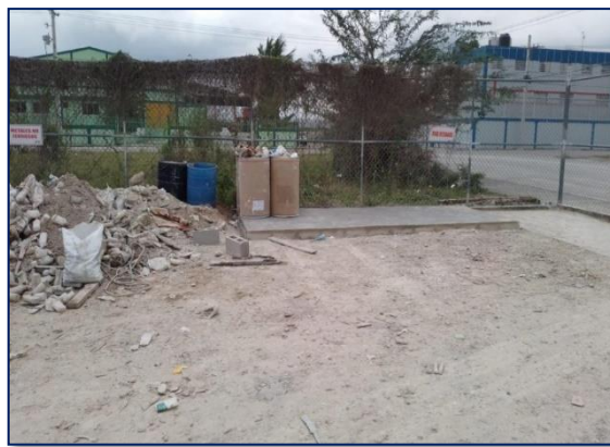
Foto 4.21F Construcción Base de Cemento Residuos Solidos
