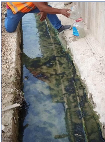
Foto 6.1 Lugar Toma de Muestra, en Canal Drenaje
