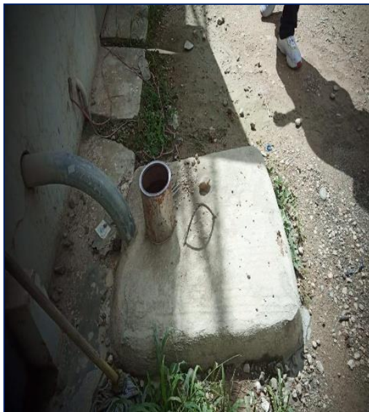
Foto 2.24C Tubos de Descarga de Líquidos Oleosos
