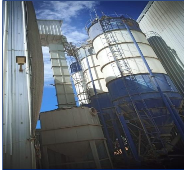
Foto 2.20 (3) Silos de Almacenamiento de Materiales
