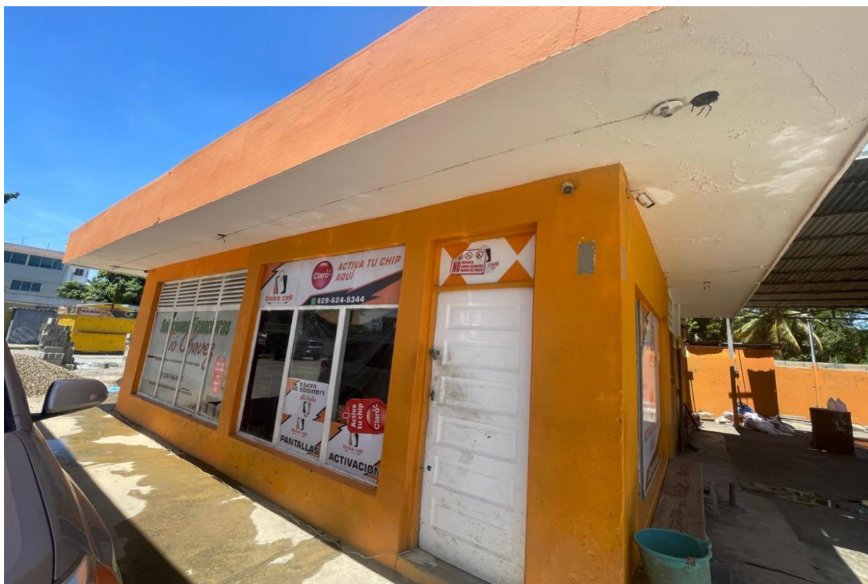
Local comercial a ser demolido
