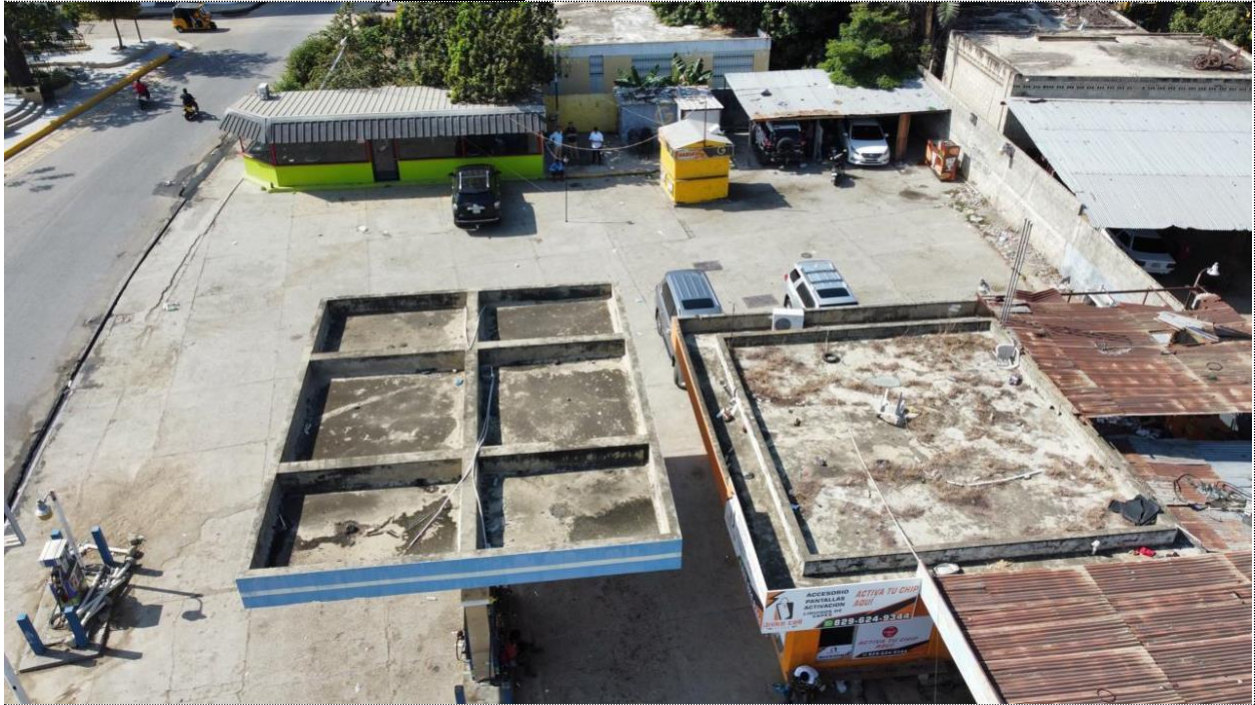
Foto: Vista aerea de la estacion Mao.
