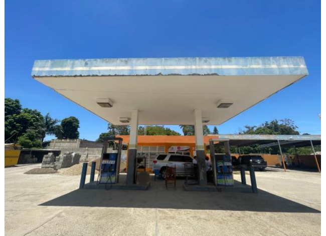
Foto Marquesina de la estacion
