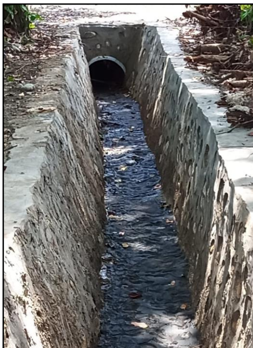
Foto 1.8 Tubería de Descarga a la Salida
