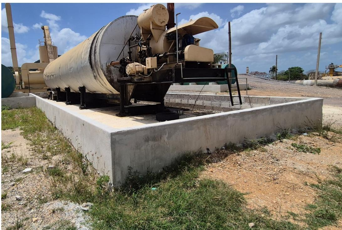
**Figura No. 16.- Tanque de almacenamiento de AC-30.**
