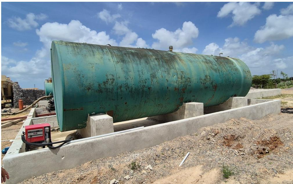
**Figura No. 15.- Tanque de almacenamiento de combustible.**
