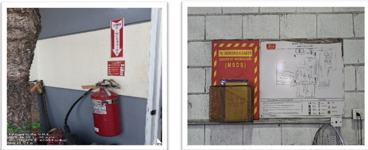
Imagen 1.1-6. Extintores distribuidos por todas las instalaciones, ruta de evacuación en mapa y carpeta con los MSDS
