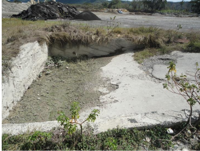
Figura No. 16.- Fosa de lavado de los camiones.
