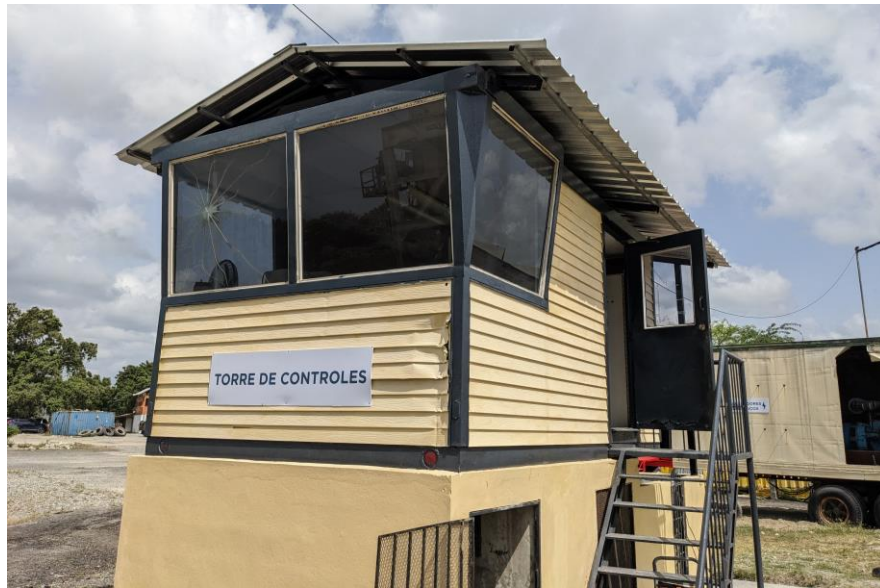
Figura No. 2.- Cuarto de control
