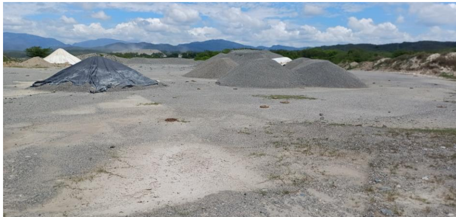
Figura No. 6.- Acopio de los agregados
