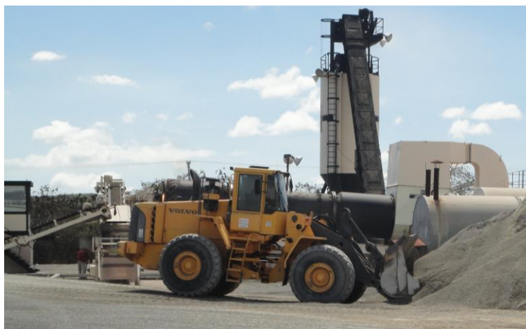
Figura No. 21.- Pala mecánica.
