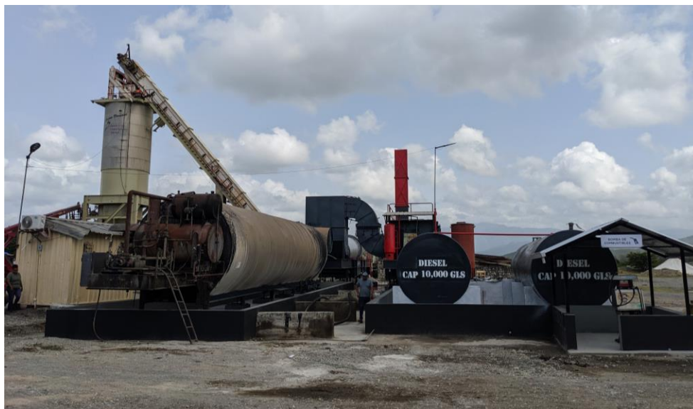
Figura No. 3.- Vista general de la planta de asfalto.
