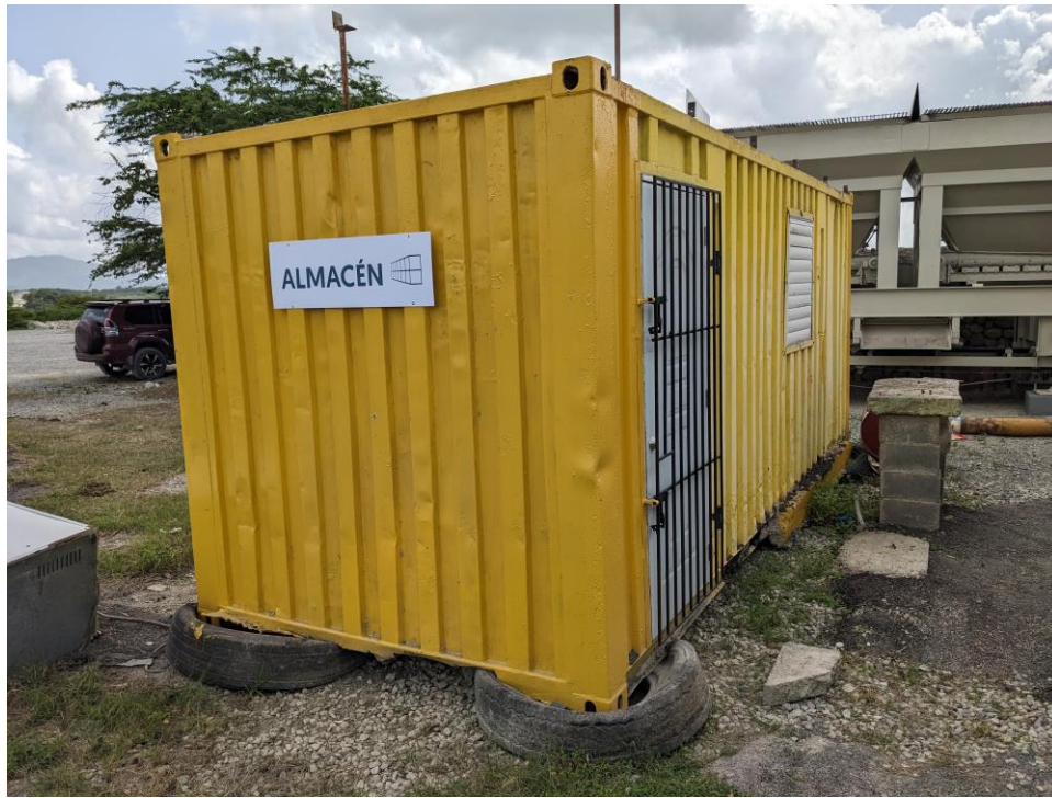
Figura No. 7.- Furgón donde se almacenan los aditivos y químicos.
