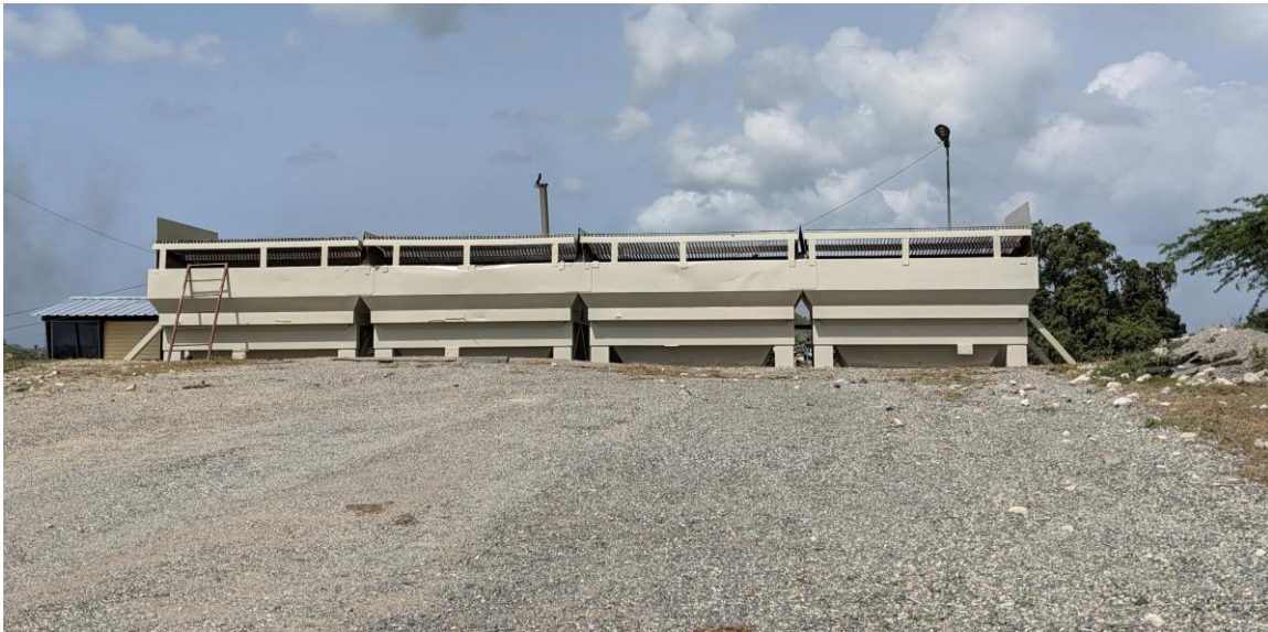
Figura No. 12.- Tolva de agregados.
