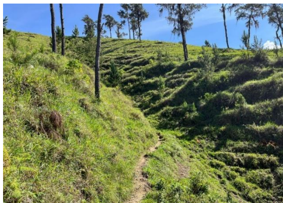
Foto No.1. Drenaje de escorrentía del proyecto
