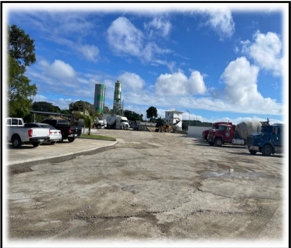
Imagen Error! No text of specified style in document.-1. Vista de la planta de hormigón armado
