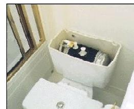
Conforme se agote la vida útil de los modelos convencionales, se sustituyen por los inodoros eficientes. En aquellos casos donde el valor e importancia del agua lo justifique, la sustitución debería realizarse a pesar de que los inodoros convencionales no hayan agotado su vida útil. La diferencia en costo se compensará ampliamente con el ahorro en el consumo del agua.
